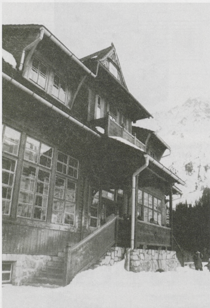
35. Schronisko nad Morskim Okiem, elewacja frontowa (stan obecny) (fot. M. Kulig).
