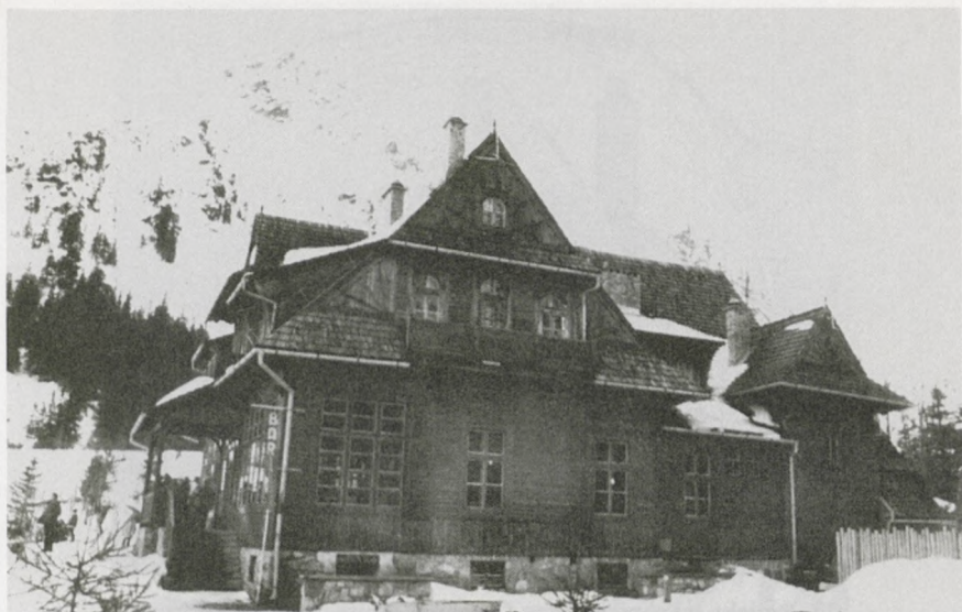
36. Schronisko nad Morskim Okiem, elewacja wschodnia (stan obecny) (fot. M. Kulig).
