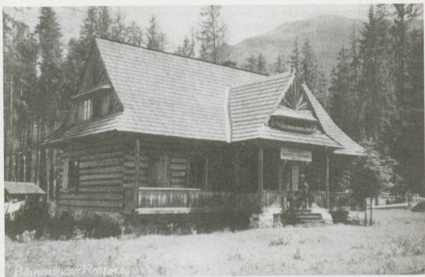
20. Schronisko PTT w Roztoce przed rozbudową (MT-ZA, sygn. AF/3347/MT/II-019 (rep. AF/N/20037/XXII-4); rep. M. Kulig).
