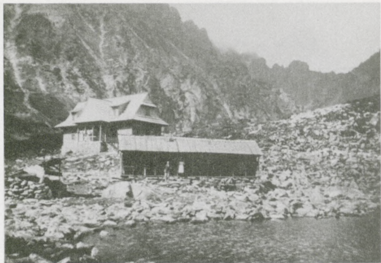
59. Stare schronisko PTT w Dolinie Pięciu Stawów Polskich przed rozebraniem i nowe schronisko w pierwszej fazie budowy (1924?) („Wierchy”, 18: 1948, s. 251; fot. T. i S. Zwoliński).
