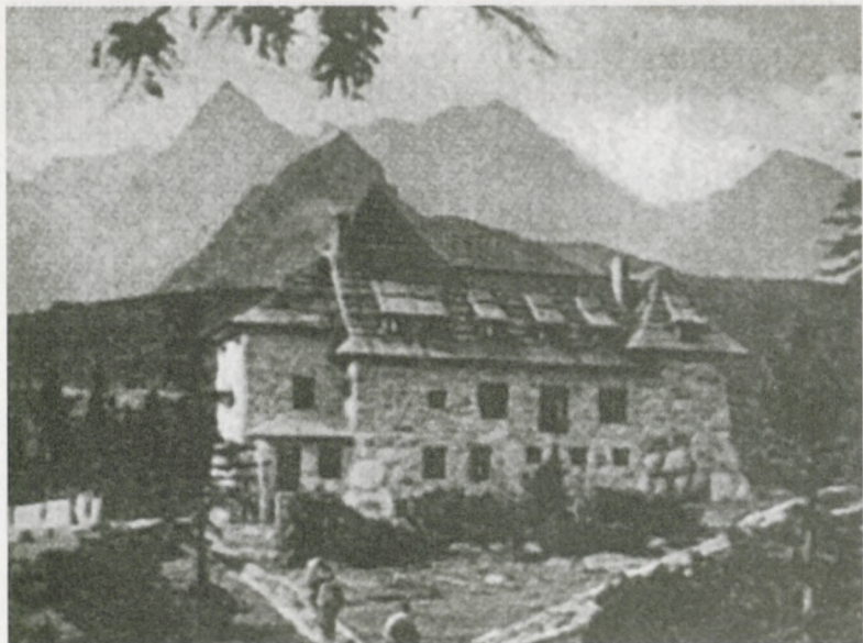
55. „Murowaniec”, elewacja północna, w tle Kościelec i Świnica ( Budowa terenów i urządzeń sportowych , Warszawa 1928, s. 309).
