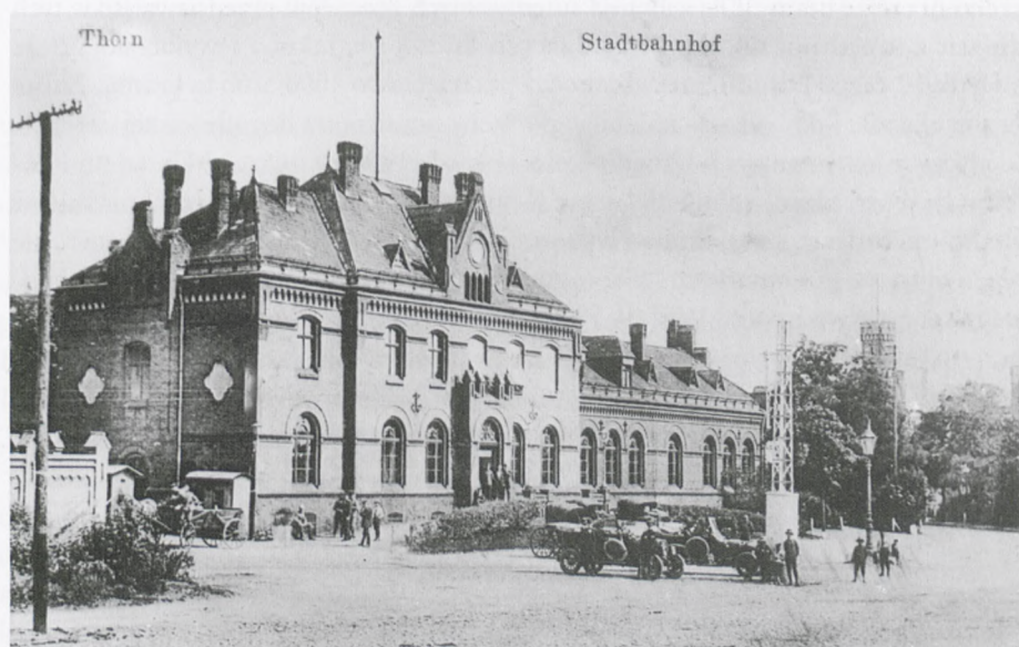
Il. 31. Dworzec Toruń-Miasto wybudowany w 1888 r. Widok od strony ul. Piastowskiej. Fot. ok. 1915 r.
