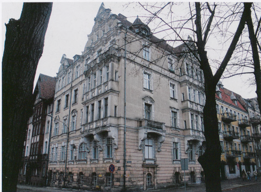
Il. 52. Kamienica czynszowa na rogu ul. Piastowskiej ( Wilhelmstrasse ) i Jagiellończyka ( Albrechtstrasse ).
