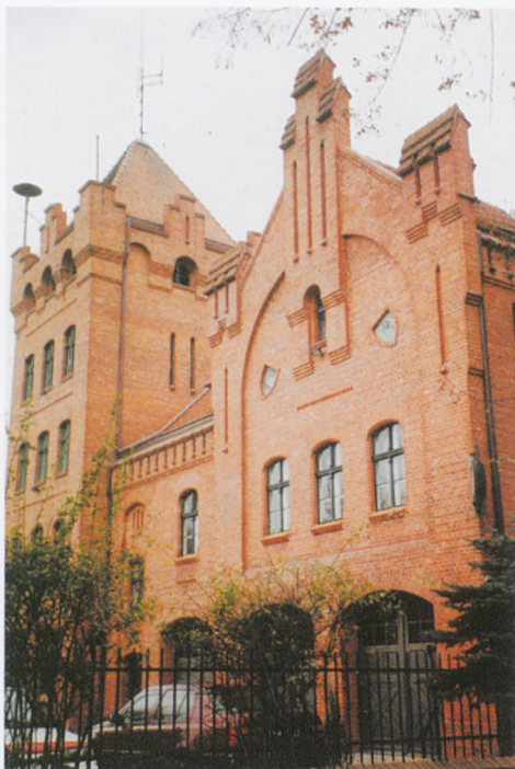
Il. 102. Fragment budynku straży pożarnej przy ul. Wały gen. Sikorskiego, widok od strony pln.-zach.
