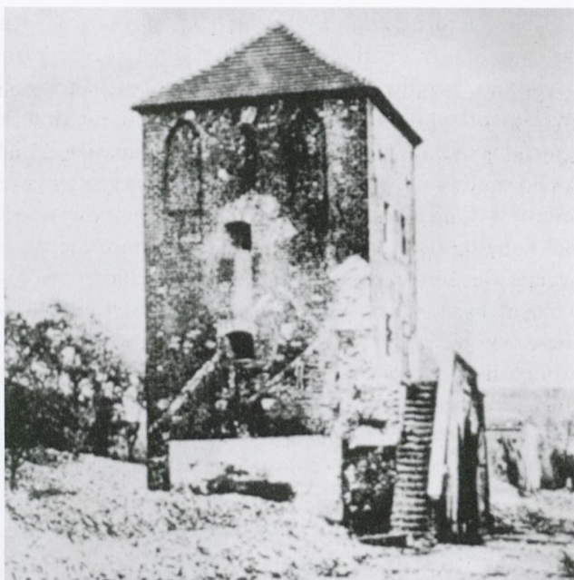
Il. 35. Brama św. Katarzyny rozebrana w 1884 r. Fot. ok. 1880 r.
