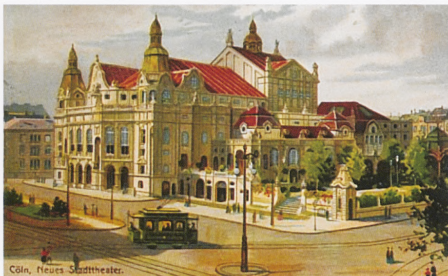
Il. 183. Kolonia – Neues Stadttheater , wybudowany w latach 1899–1902 według projektu Carla Moritza.
