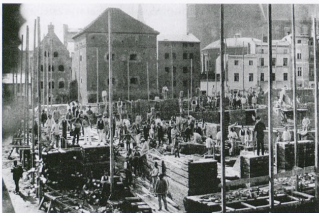
Il. 193. Teatr Miejski w trakcie budowy. Fot. 1904.
