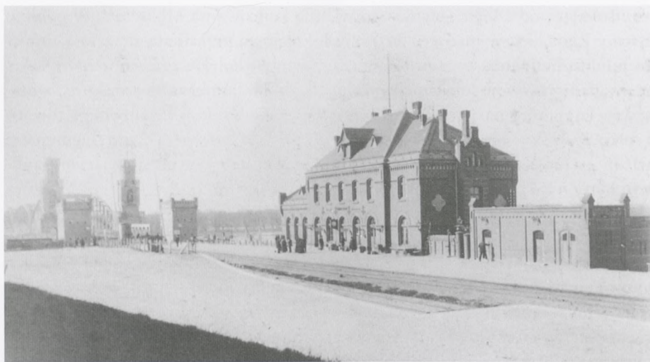
Il. 30. Dworzec Toruń-Miasto wybudowany w 1888 r.
