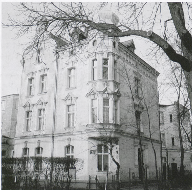
Il. 75. Kamienica przy ul. Bydgoskiej 78.
