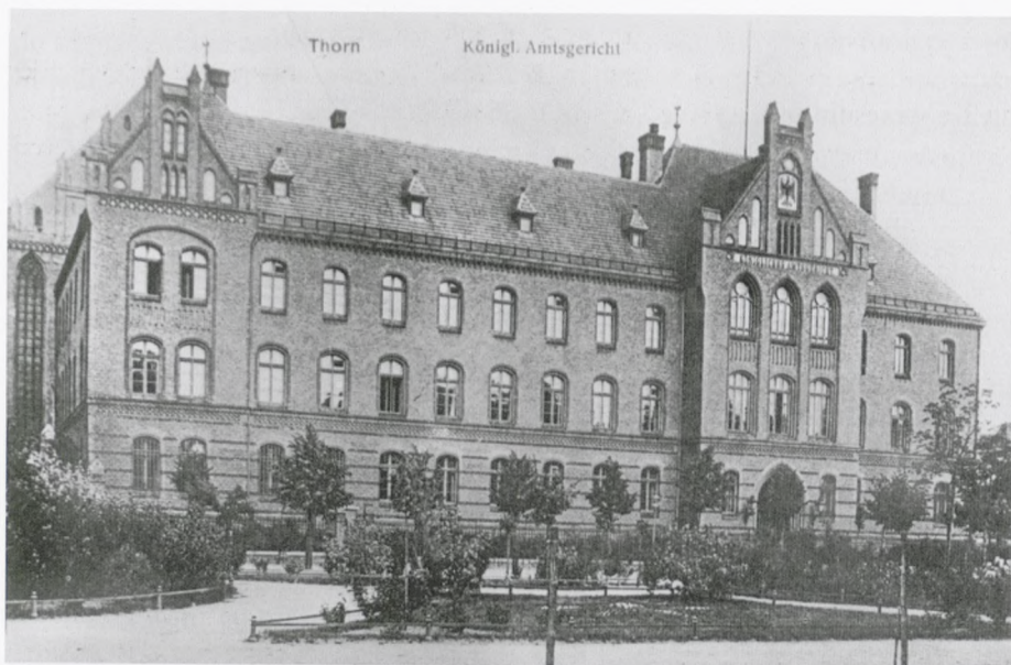
Il. 108. Budynek sądu okręgowego ( Königliches Amtsgericht ) przy ul. Fosa Staromiejska.
