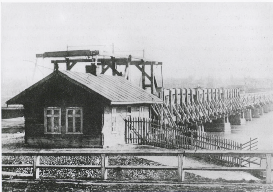
Il. 28. Most drewniany przez Wisłę.
