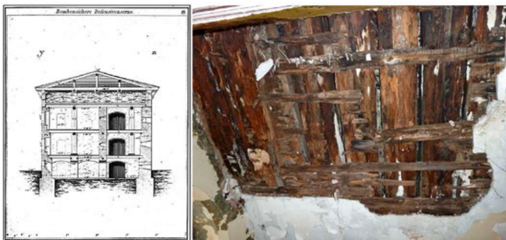
Ryc. 3. A – Schemat budynku obronnego z drewnianym stropem bomboodpornym. Moritz Karl Ernst von Prittwitz und Gaffron, Beiträge zur angewandten Befestigungskunst, erlaeutert durch Beispiele aus den neuern preussischen Befestigungsanlagen, auf 100 Taf, Posen 1836, Taf. 19 ; B – Pozostałości stropu bomboodpornego. Zdjęcie ze zbiorów W. Skrobota.
