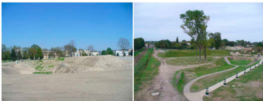
Ryc. 5. Twierdza Zamość. A – odtworzony częściowo wał i fosa reduty frontu wschodniego; B – zaznaczone w terenie dawniej całkowicie zniwelowane raweliny frontu południowego. W głębi rawelin Bramy Szczepiebrzeskiej. Fot. Jan Janczykowski, 30.04.2012 i 07.09.2012.
