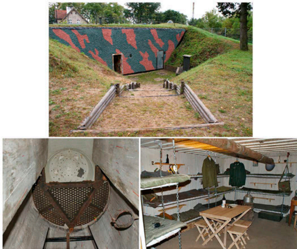
Ryc. 1. Schron typu 502 w Pisz: A – dziedziniec i ściana wejściowa; B – dzwon 90P9; C – wnętrze izby żołnierskiej. Fot. Adam Żywiczyński.
