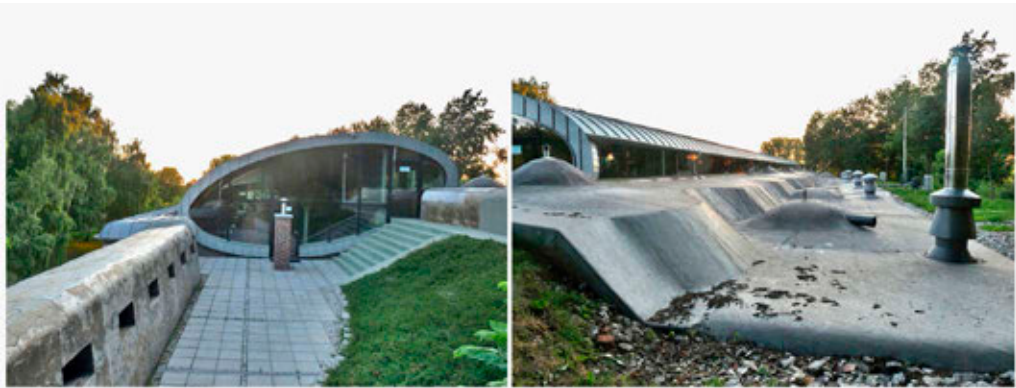
Ryc. II. Ingerencja architektoniczna w unikatowy w skali europy fort pancerny 47a „Węgrzce”, wynikająca z niezrozumienia podstawowych cech zabytku: A – manierystyczna i pretensjonalna forma nadbudowy, przecięcie oryginalnego przedpiersia, B – zakłócenie sylwety fortu poprzez jej podniesienie. Fot. J. Środulska-Wielgus.
