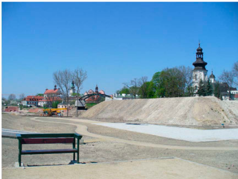
Ryc. 4. Twierdza Zamość. Zaznaczony w terenie „śląd” nieistniejącego czola bastionu I. W głębi kładka pieszka, łącząca przecięte torem kolejowym elementy umocnień. Fot. Jan Janczykowski, 30.04.2012.
