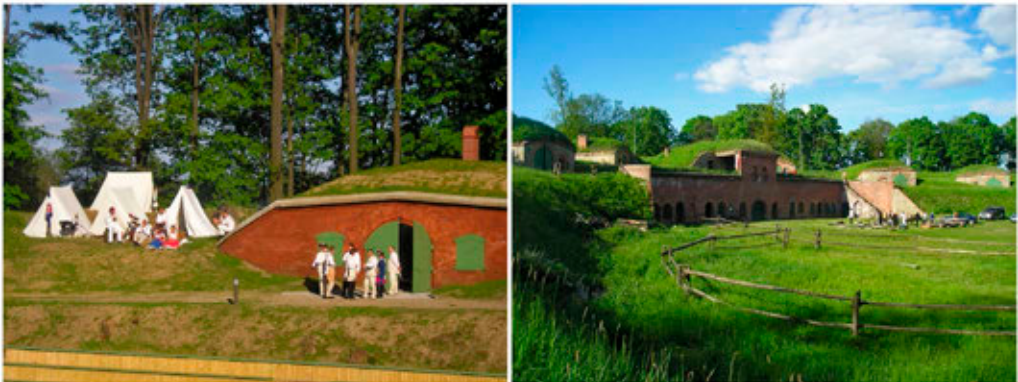
Ryc. 3. Twierdza Nysa: A – Adaptacja Fortu Wodnego. Przykład integracji nowych funkcji z dawną strukturą obiektu; B – Wzorowy przykład niskonakładowego udostępnienia Fortu 4. Fot. J. Środulska-Wielgus.
