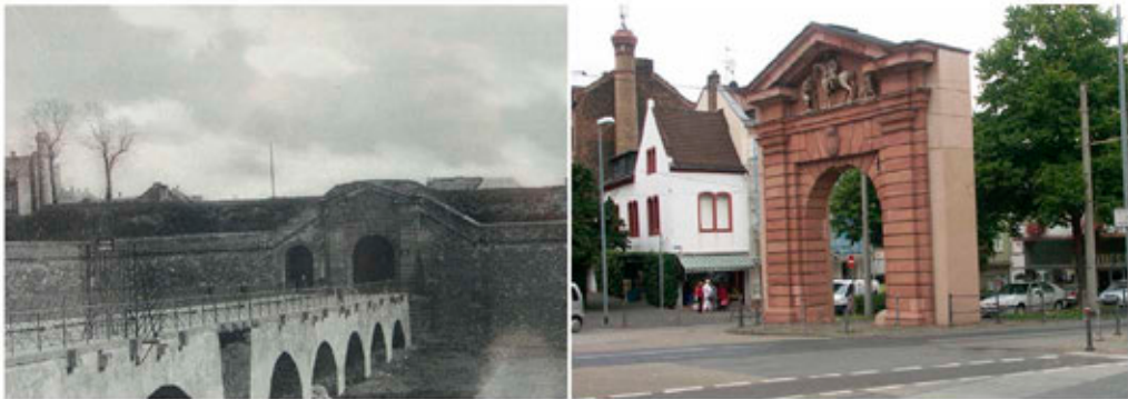
Ryc. 2. Moguncja – fotografia bramy w wale obronnym oraz jej „preparat” konserwatorski. Foto: autor 2008.
