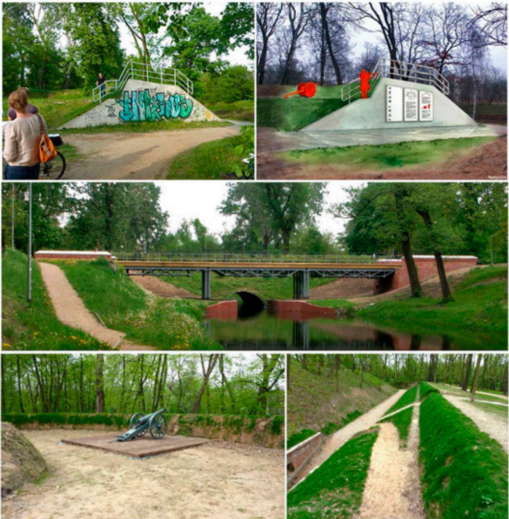
Ryc. 3. Przystosowanie fortu Bema (P-Parysów) w Warszawie do funkcji parkowo-rekreacyjnych (2004-2010): A, B – odbudowa nasypu wału piechoty z niezrealizowanym projektem tablic informacyjnych; C – reprofilacja fosy i konserwacja mostu; D – częściowe zagospodarowanie terenu poprzez ustawienie
