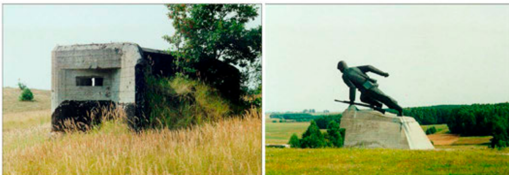
Fot. 1, 2. Schron bojowy pozycji mławskiej, zbudowany w lecie 1939 r., oraz pomnik z roku 1964 w Uniszkach Zawadzkich przy drodze krajowej nr 7 (fot. P. Wodziszłowski).
