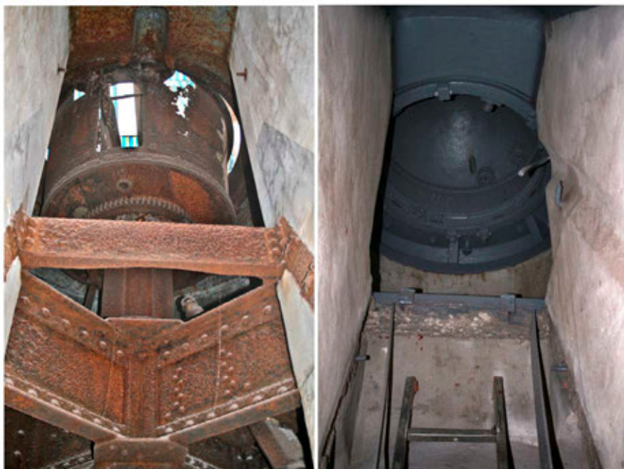
Ryc. 6. Fort 44 Tonie. A. Fragment wieży wysuwalno-obrotowej w trakcie konserwacji; B. Kopuła wieży obserwacyjnej, po konserwacji. Fot. H. Rojkowska-Tasak
