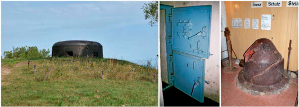
Ryc. 3. Schron 113d w Bakalarzewie: A – Kopuła 20P7; B – drzwi ciężkie typu 434PO1; C – ekspozycja w schronie. Fot. Adam Żywicznyński.
