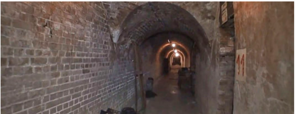
Ryc. 7. Poterna obwodowa Fortu Stiehle. Fot. Fiodor Muntjan.
