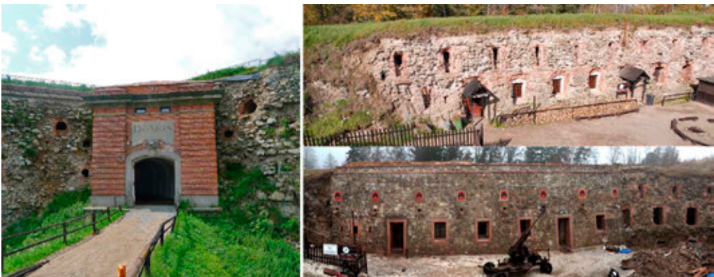
Ryc. 2. Twierdza Srebrna Góra: A – Brama Orła po pracach konserwatorskich; B – elewacja dziedzińca Bastionu Dolnego przed i w trakcie prac rewaloryzacyjnych (fot. M. Małachowicz).
