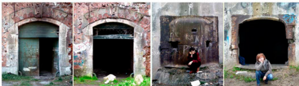
Ryc. 2. Początek XXI wieku. Drastyczne okradanie fortów Twierdzy Kraków z elementów pancernych. A – wrota poterny Fortu 52 „Borek”, B – strata unikatowego, ostatniego zachowanego w Polsce sponsonu pancernego – Fort 50 „Prokocim”. Fot. K. Wielgus.
