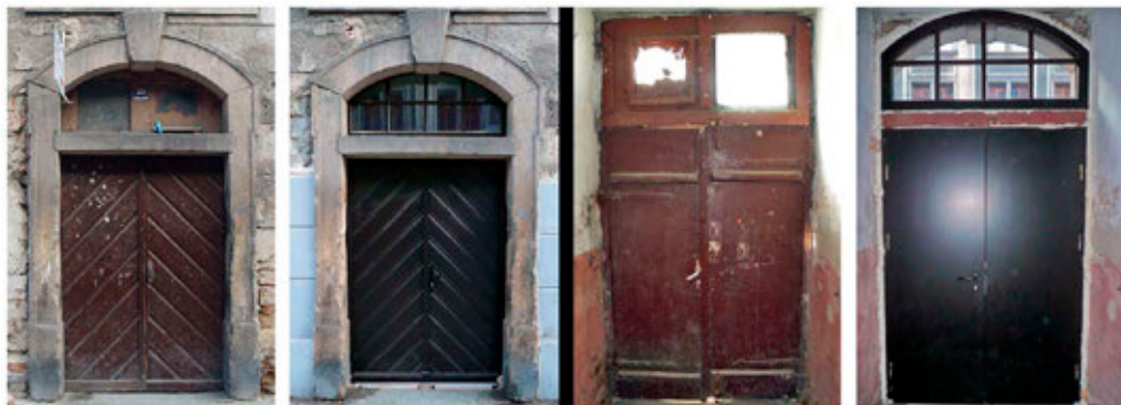
Fot. 5. Kłodzko, Koszary No5. Zestawienie awersu i rewersu drzwi przed wymianą i po montażu nowych zamknięć. Oryginalne drzwi z poł. XVIII w. odjechały wraz z firmą montującą nowe zamknięcia. Dawne skrzydła, mimo powierzchniowych zniszczeń, mogły po przeprowadzeniu prac konserwatorskich służyć jeszcze wiele dziesiątek lat. Fot. G. Basiński 2011-2012.
