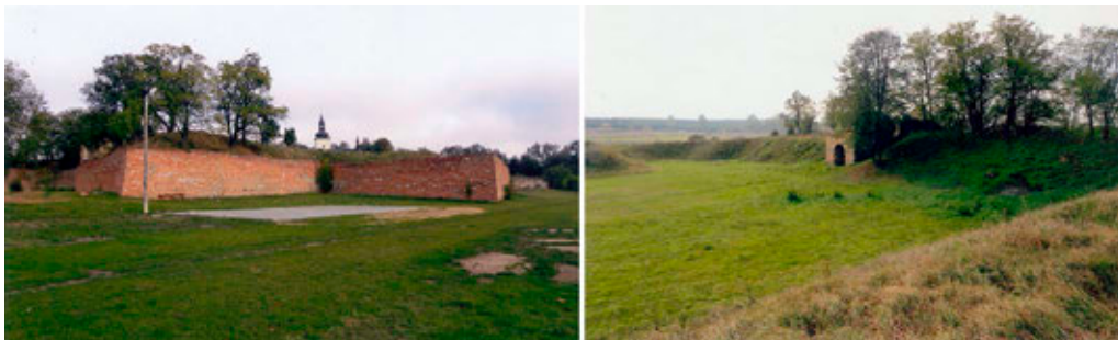
Ryc. 3. Zamek w Dankowie: A – południowo-wschodni narożnik obwodu obronnego, dwa półbastiony formujące kleszcz; B – dziedziniec obwodu obronnego, widok z wału frontu zachodniego w kierunku frontu południowego z Bramą Krzepicką. Foto: Mirosław Holewiński, 2012.
