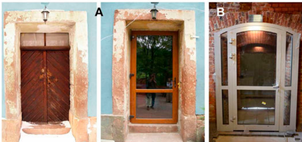
Fot. 4. A. Srebrna Góra, Koszary podłużne, drzwi dwuskrzydłowe z nadświetłem (1776 r.), widok przed i po montażu dodatkowego zamknięcia. B. Srebrna Góra, Donżon, wiatrołap drzwi wejściowych do kazamaty oficerów. Fot. G. Basiński 2011-2012.
