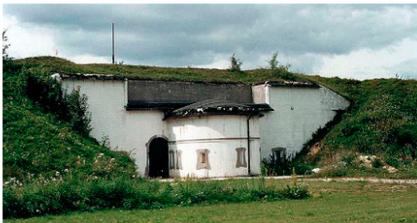
Ryc. 5. Twierdza Brześć, Prochownia Kobylany. Charakterystyczne dla szkoły rosyjskiej dzieło magazynowe wzbogacone o elementy obrony czynnej (wał bojowy, kaponiera szyjowa), fot. G. Michalska 2003.
