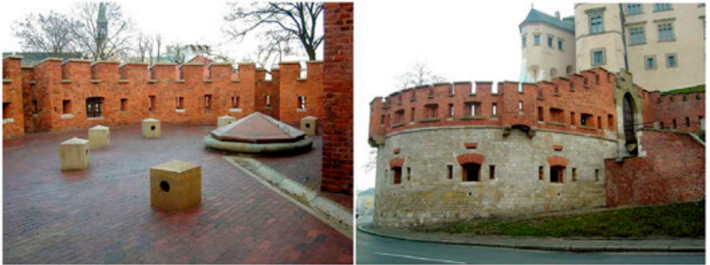
Ryc. 4, 5. Taras bastii, stan po konserwacji w 2003 r.; Widok bastii i bramy od północy, stan po konserwacji w 2003 r. Fot. P. Stępień.
