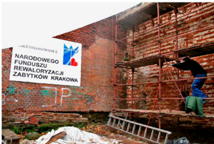
Ryc. 2. Bastion III Kleparz. Prace zabezpieczające kurtynę, fot. H. Rojkowska-Tasak.
