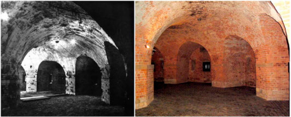
Ryc. 2, 3. Kazamaty bastii – stan przed konserwacją (lata 80. XX w.). Archiwum Zamku Królewskiego na Wawelu; – stan po konserwacji w 2003 r. Fot. P. Stępień.
