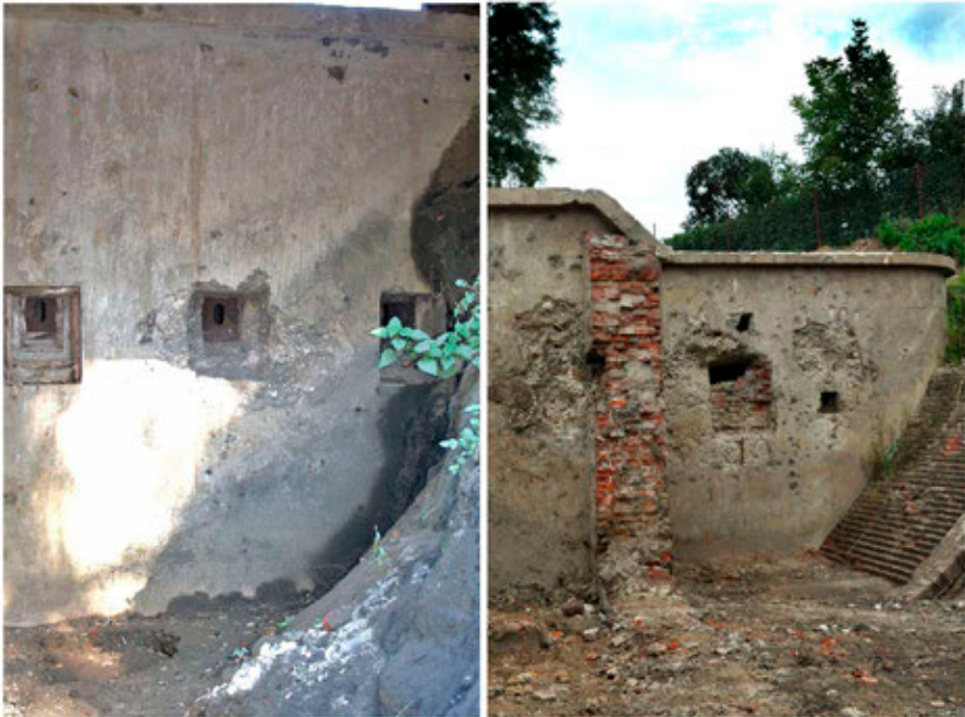
Ryc. 4. Fort Fort 49 Krzesławice. A. Odkopywana kaponiera boczna, miejsce straceń. Fot. H. Rojkowska-Tasak; B. Odkopana kaponiera czołowa ze śladem muru Carnota i wtórnie ukształtowanym zasypem fosy przy czole kaponiery. Fot. F. Dziadoń.
