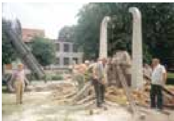
15. Pomnik ofiar zbrodni hitlerowskich w trakcie budowy
