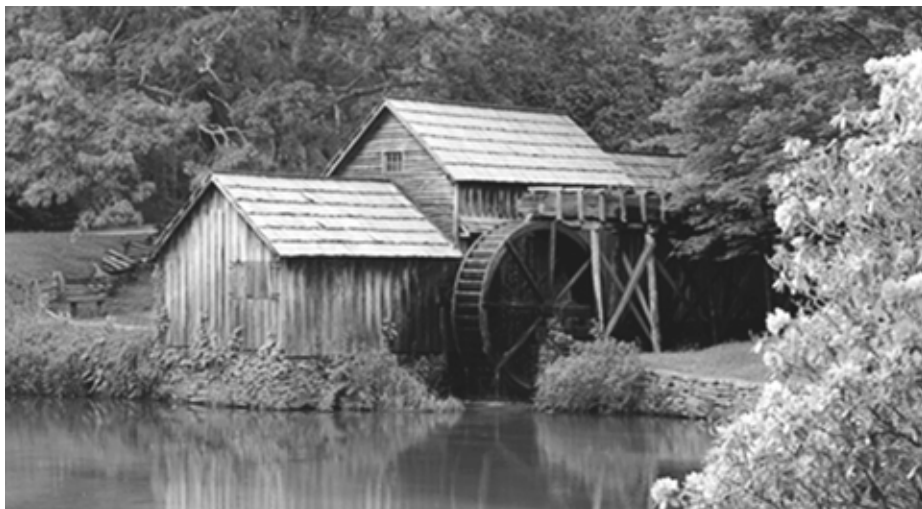
Ryc. 4. Młyn wodny z kołem nasiębiernym. Woda napływa na koło za pomocą widocznej nad nim, wspartej podporami drewnianej rynny [źródło: zbiory własne].
