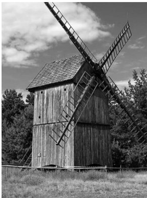
Ryc. 5. Wiatrak typu koźłowego (koźlak). Muzeum Kultury Ludowej w Osieku [źródło: Zbiory Muzeum Kultury Ludowej w Osieku, fot. Roman Skiba].
