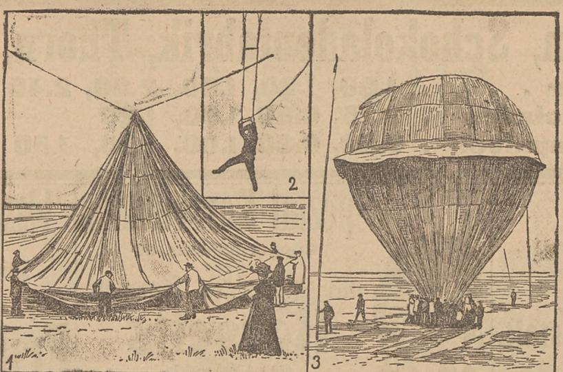
1 Die Füllung des Ballons mit warmer Luft. 2 Der Luftschiffer Thomiks während des Fluges des gondellosen Ballons. 3 Die Montgolfiere beim Aufstieg auf dem Flugplatze in Johannisthal.
