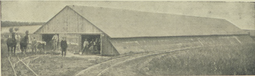
Abb. 32. Trockenschuppen (Lagerraum) nahe Bahnhof Kruglanken.
