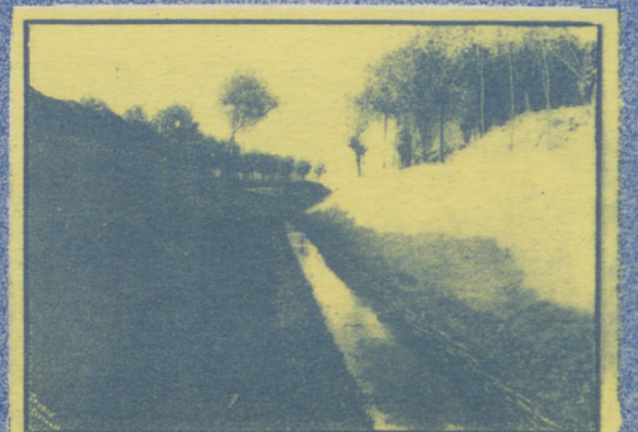
FRAGMENT BUDOWANEGO KANAŁU NA SŁONSKU
