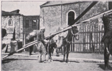
TRANSPORT DE POUTRELLES A DOS DE MULET
