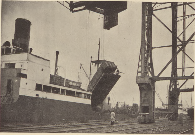
KOHLNVERLADUNG IN GDYNIA
