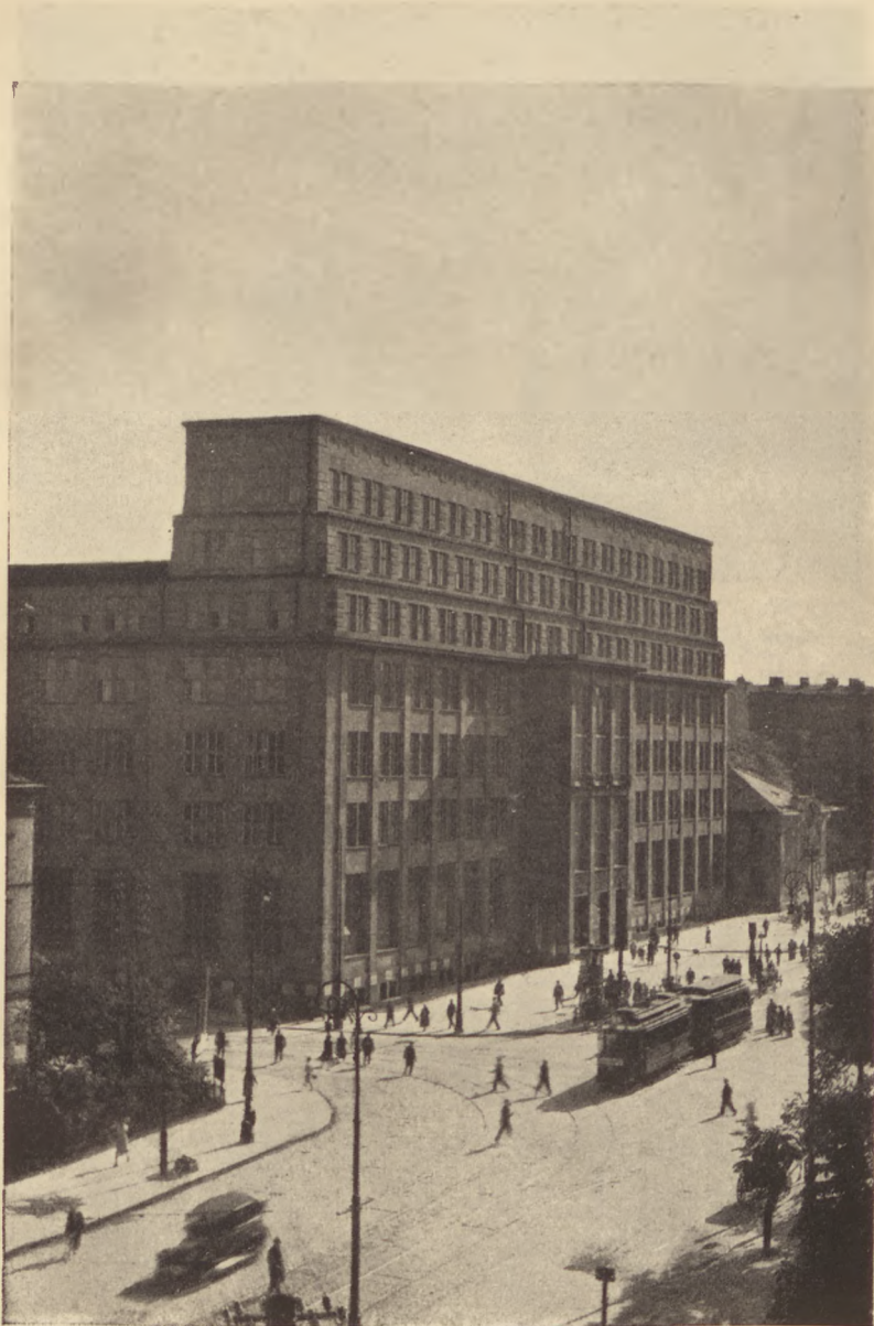
HAUPTGEBÄUDE DER BANK GOSPODARSTWA KRAJOWEGO IN WARSZAWA
