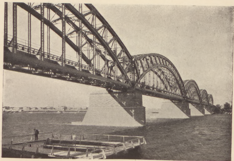
NEUE EISENBAHNBRÜCKE IN WARSZAWA
