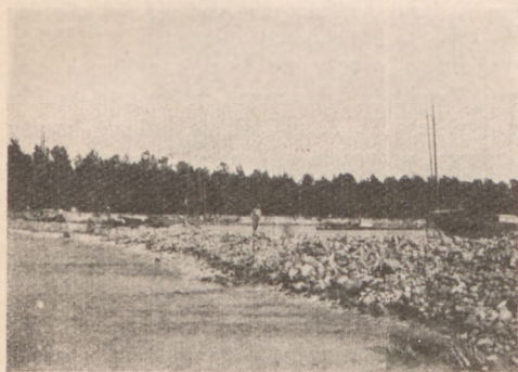
Rys. 68. Budowa główek na Wiśle.
