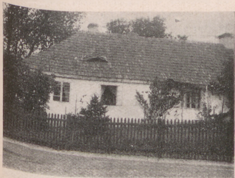
Rys. 18. Pierwsze mieszkanie lekarza zakładowego, w północnej przybudówce domu Nr. 11.
