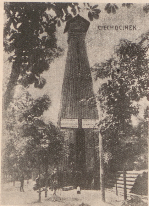
Rys. 13. Wieża nad źródłem Nr. 11, podczas świdrowania otworu.
