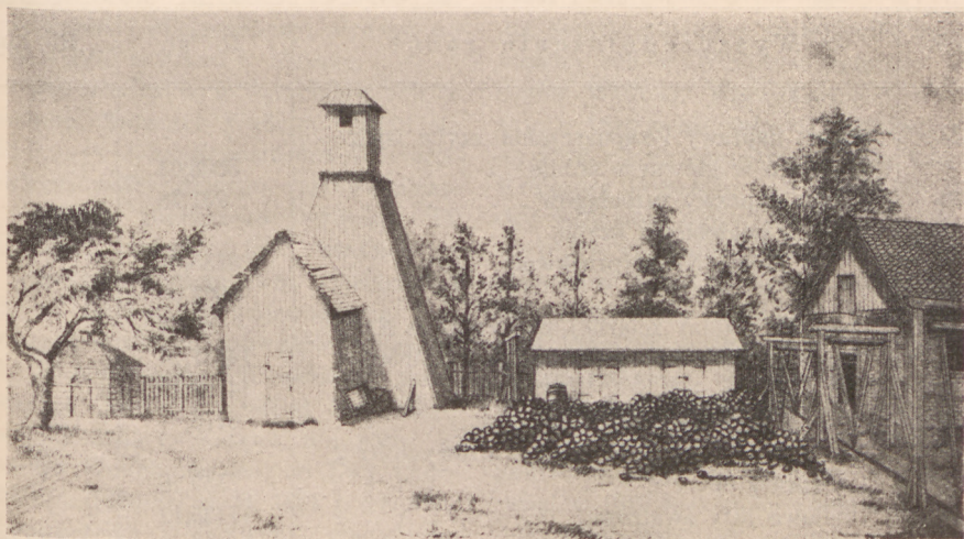
Nr. 14. Dawne podwórze maszynowni warzeźnianej przy źródłach Nr. 2 i Nr. 3: kuźnia, hohrloch źródła Nr. 2 (nowe), szopa pożarna, dyszle pociągowe, służące do przesyłania siły maszyny parowej do źródeł Nr. 1, Nr. 2, Nr. 3 i maszynownia warzeźniana. Dyszle zaprojektował naczelnik Englert w 1846 r. Zniszczone zostały przez dzierżawcę salin Jen. Glinkę-Mawrina po zmianie pomp.
