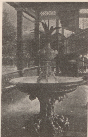
Rys. 50. Stara pijalnia pod galerją spaco- rową.
