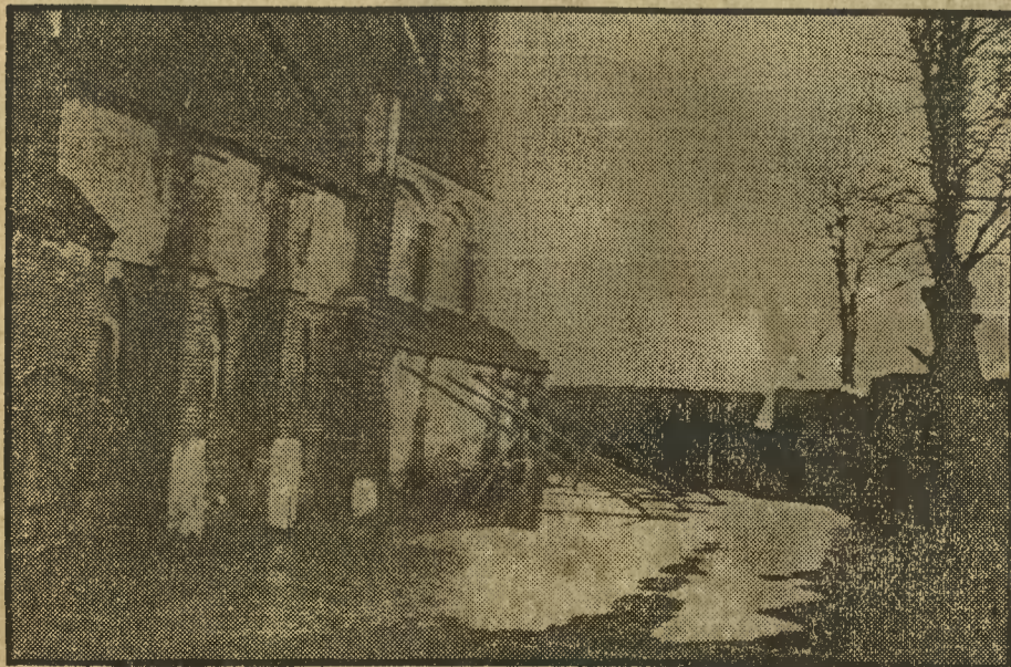
Podparta belkami nisza starej Fary śwleckiej.
