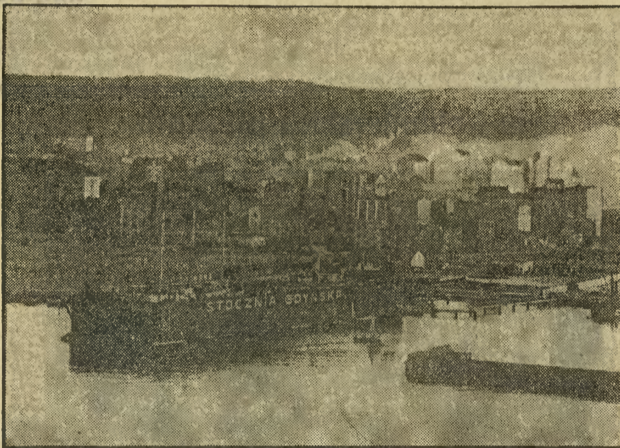
Fotografia nasza przedstawia widok m. Gdyni z nadbrzeża Śląskiego z widocznym na pierwszym planie dokiem pływającym do naprawy okrętów.
