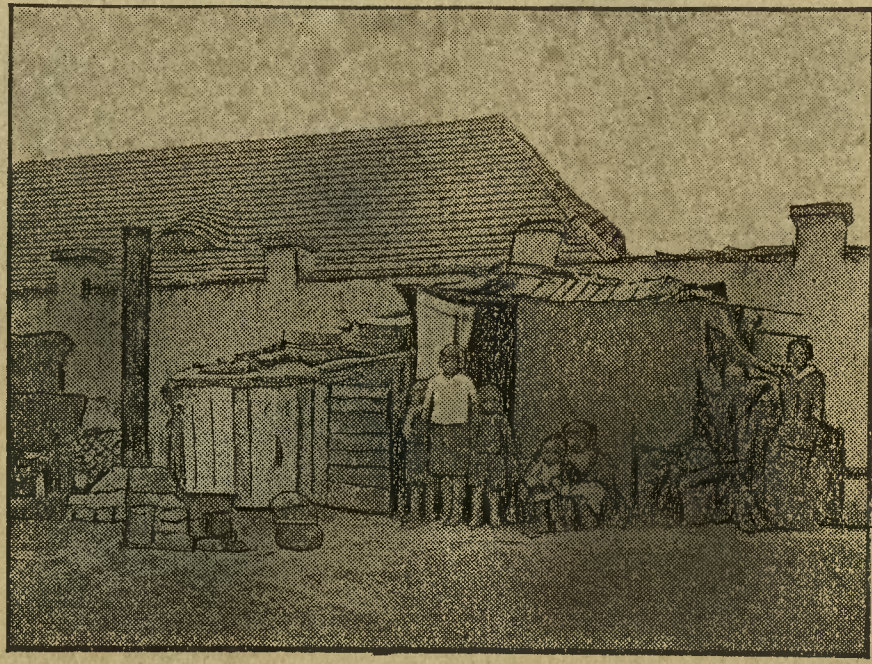
DWIE NĘDZNE BUDY PRZYLEGAJĄCE DO TERENU SZKOŁY PODCHORĄŻYCH. W lewej, mniejszej budce, nie można było wstawić łóżka, więc ludzie tam śpiją na słomie, podobnie do zwierząt. Przed budą prymitywny piecyk z długą rurą blaszaną.
