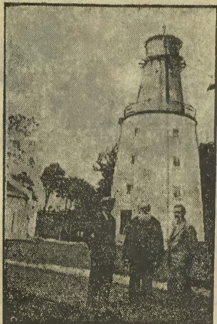
Latarnia morska w Rozewiu.
