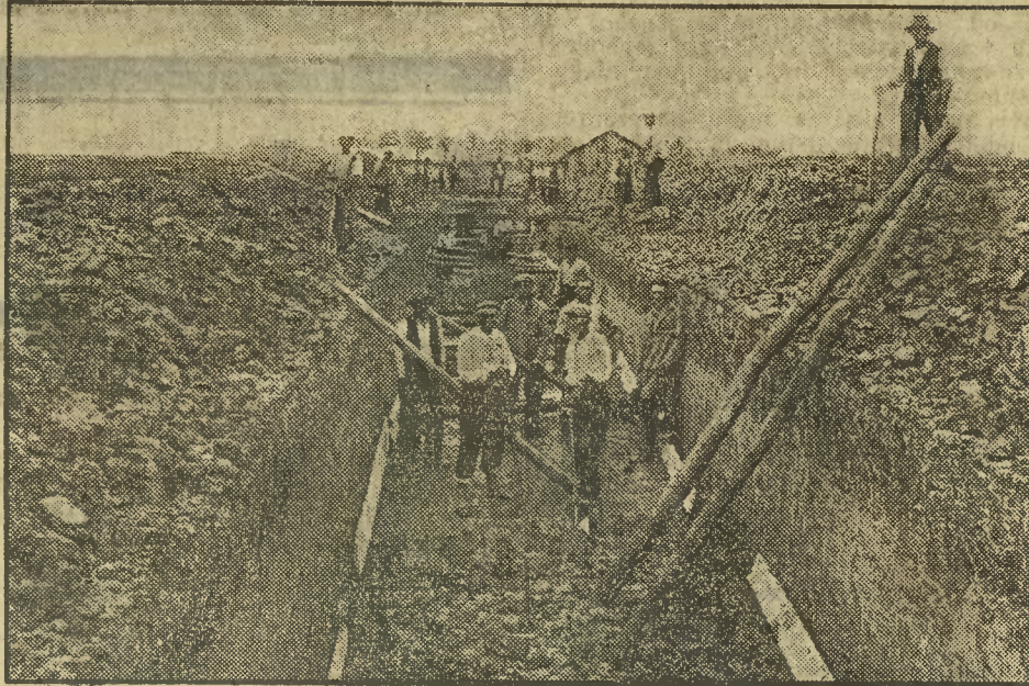
Roboty niwelacyjne na lotnisku w Inowrocławiu.
