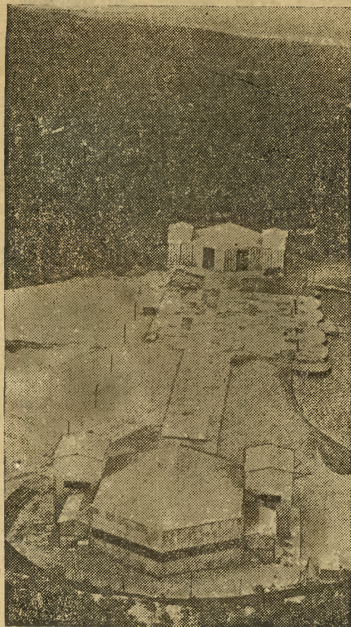
Na południo-wschodzie Francji między Atlantykiem, rzeką Garonną, oraz dolinami został zbudowany wielki francuski port dla hydroplanów, w miejscowości Biscarosse. Na fotografii port w Biscarosse widziany z lotu ptaka.
