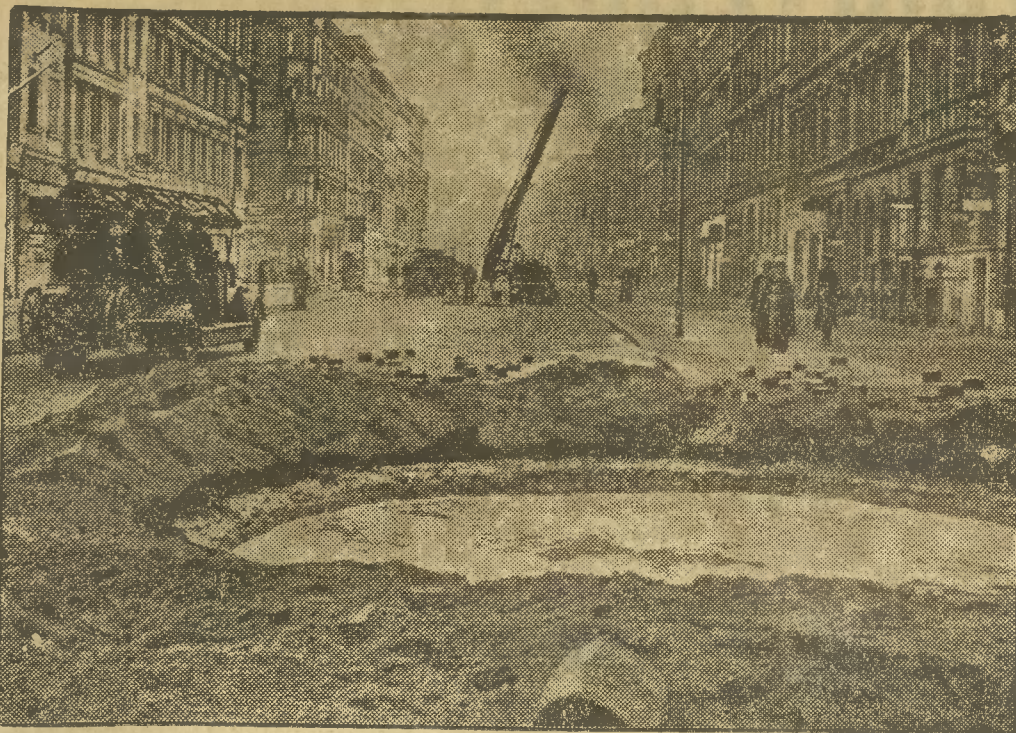
Jedna ze ślepych bomb lotniczych wyrwała na ulicy bruk i zrobiła lej, podobny do lej- jów, jakie widziano dawniej na froncie. Bomba uszkodziła rurę wodociągu. Woda zalala cały lej.
