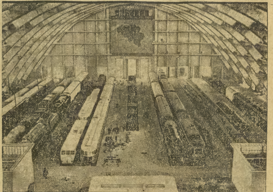
Na wystawie światowej w Brukseli ogromna hala poświęcona została współczesnemu kolejnictwu. Można tam oglądać najnowsze typy lokomotyw, wagonów i urządzeń kolejowych.
