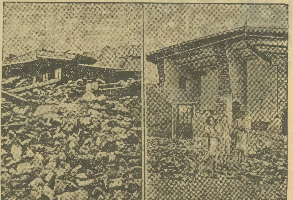
Nadeszły już zdjęcia z brytyjskiego Beludżystanu — ziemi nawiedzonej straszliwym trzęsieniem ziemi. Z lewej strony — ruiny stacji kolejowej w Sariab, położonej o 6 mil od Quetty. Z prawej — ruiny domów w głównym mieście Beludżystanu Quetta, gdzie na gruzach zakwita już nowe życie.
