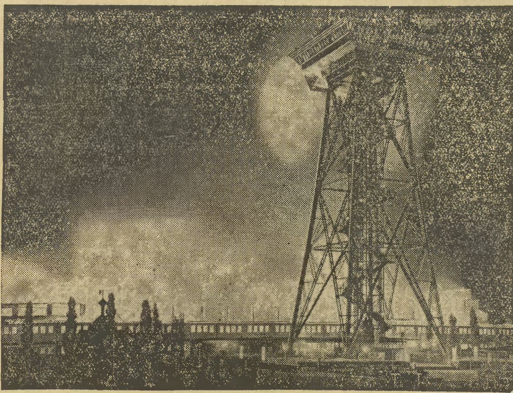
W hali IV w centrum wystawy radiowej w Berlinie wybuchł pożar, który zniszczył halę i restaurację wieży nadawczej.
