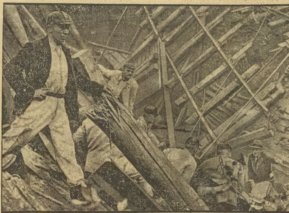
Na miejsce katastrofy w Berlinie, gdzie zawalił się tunel kolei podziemnej, sprowadzono górników z Westfalji, którzy, jako specjaliści w akcji ratunkowej, mają zaspawanych robotników wydobyć.
