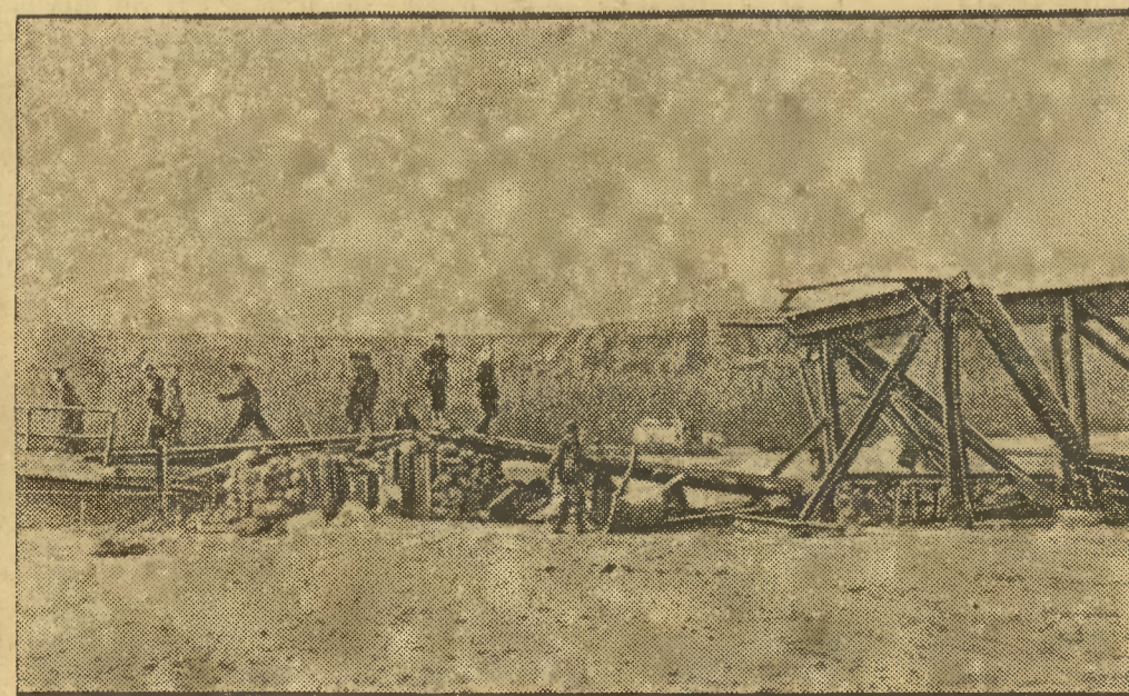
Zniszczone mosty na rzece Jarama poniżej Madrytu zostały prowizorycznie odbudowane przez saperów armii generała Franco. Madryt został odcięty od drogi prowadzącej do Walencji.
