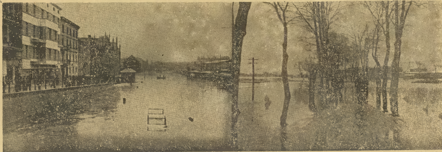
Zalane bulwary przy ulicy Hermana Frankego. Szosa zalana pod Łegnowem przed Hutą Szklą.
