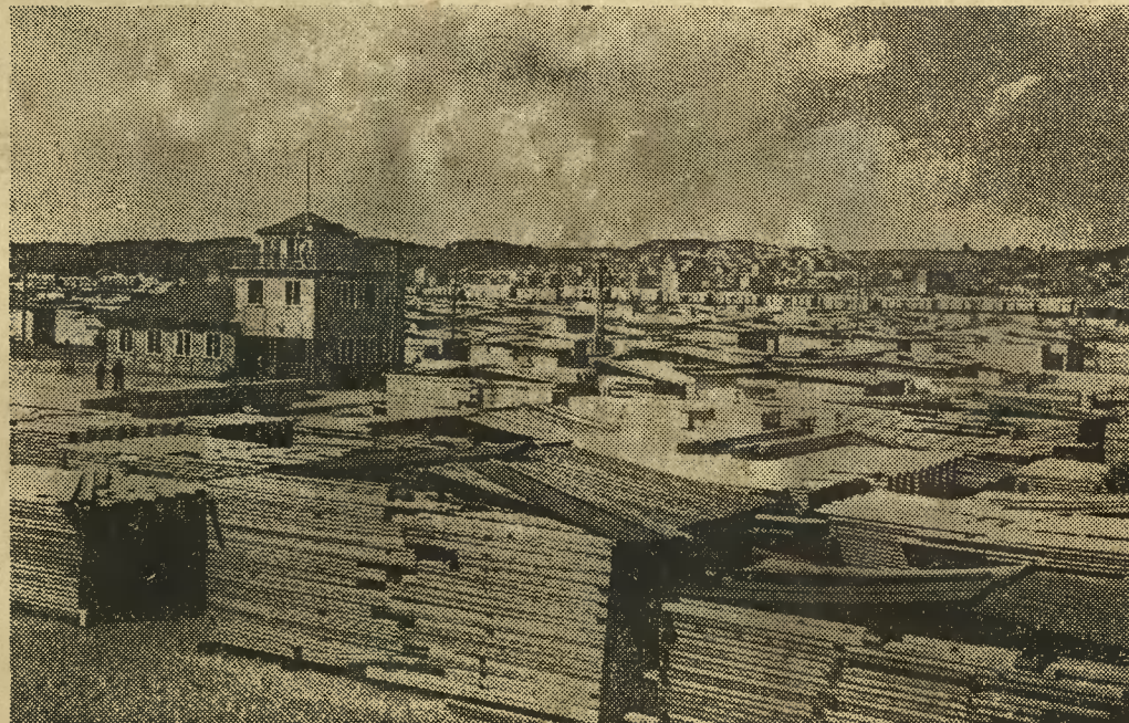
Fragment ogólnego widoku portu drzew nego. Z lewej strony budynek biurowy.
