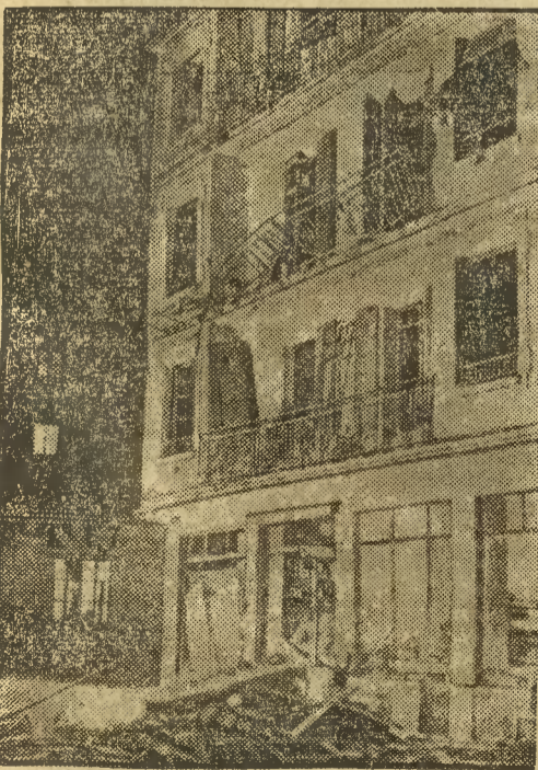
Jak już donosiliśmy, w Genewie pewien fryzjer spowodował wybuch gazu, który dosłownie całe wnętrze domu 7-piętrowego wysadził w powietrze. W katastrofie 6 osób znalazło śmierć, 15 osób uległo niebezpiecznemu poranieniu.
