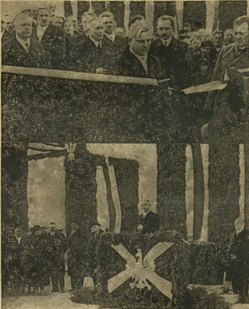
U góry: p. minister Ulrych przecina wstęgę na nowym torze kolejowym. U dołu: p. minister wygłasza przemówienie po otwarciu nowej linii.
