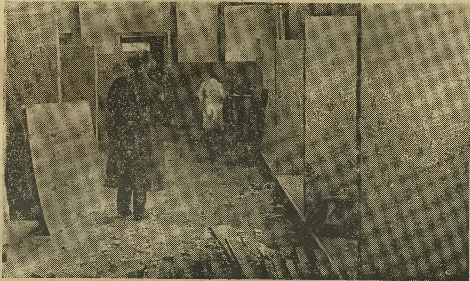
Fragment przygotowań do ogólnopolskiej wystawy radiowej w Bydgoszczy. Budowa stoisk.
