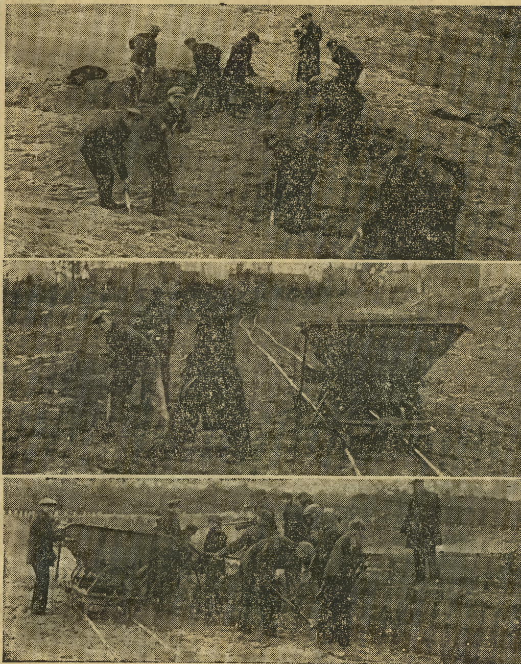
1) Gwarno i wesoło wśród „wojaków z łopatami”. 2) Ładowanie łorki zamiast ładowania karabinu. 3) Fragmenty prac na ul. Stepowej. (Fot. J. Czarnecki).
