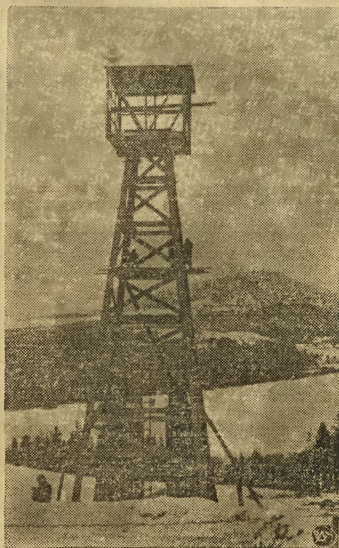
Zdjęcie przedstawia budowę mimo zimna i śniegu drugiego z rzędu szybu naftowego w Starej Wsi, w okolicy Gorlic.
