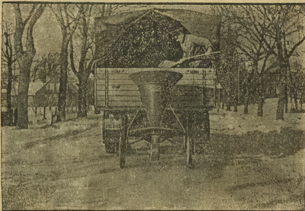
Ażby zapobiec wypadkom z powodu gołoledzi, po szosach niemieckich krążą samochody, zaopatrzone w specjalne urządzenia do rozsypywania piasku.
