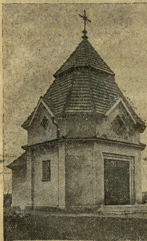
Nowowytbudowana kaplica cmentarna na cmentarzu przy ulicy Jary.
