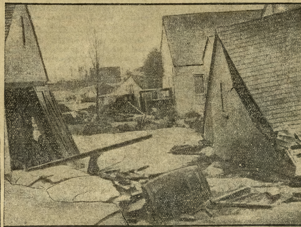
Orkan szalejący na wybrzeżu południowym Kalifornii zniszczył setki budynków. Pod gruzami obalonych domów zginęło 32 ludzi.
