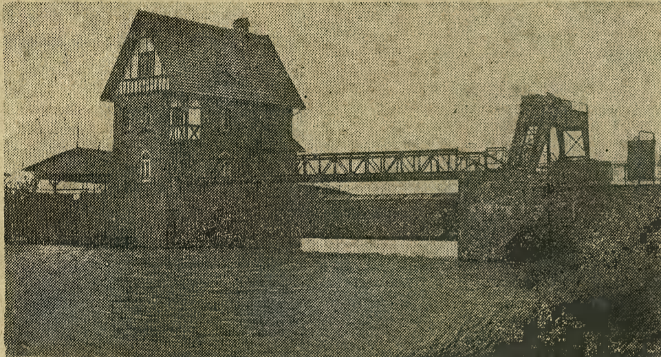
JAZ MECHANICZNY PRZY UJŚCIU RZEKI BRDY.
