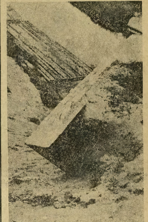
Woda i czas psują rozpoczętą budowę nowego mostu pod Rynarzewem.
