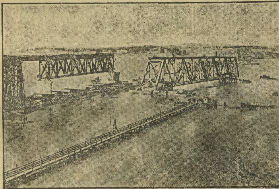
przeznaczonego dla kolei kalifornijskiej. Most ma rozpiętość 504 stóp. Do budowy użyto 1800 ton stali.
