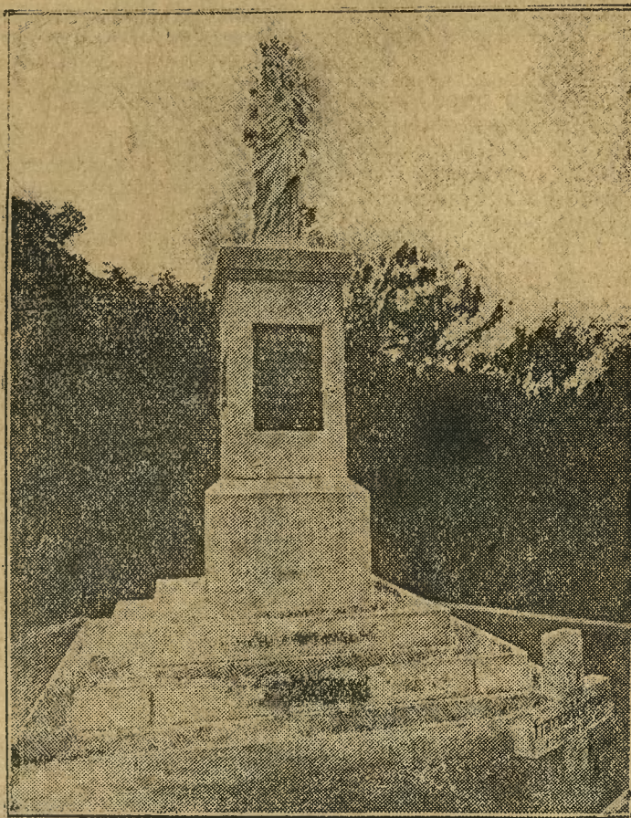
Pomnik Królowej Korony Polskiej, którego odsłonięcie odbędzie w dzień „Cudu nad Wisłą”, 15 bm. na nowym cmentarzu farnym.
