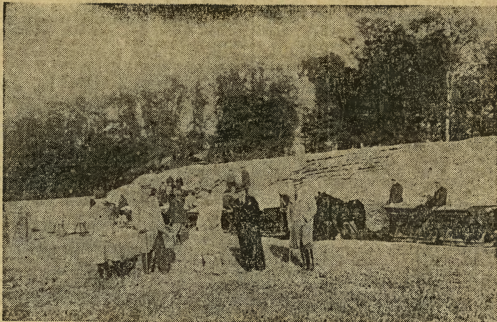
Budowa nowego wału nad Wisłą pod Chełmno.
