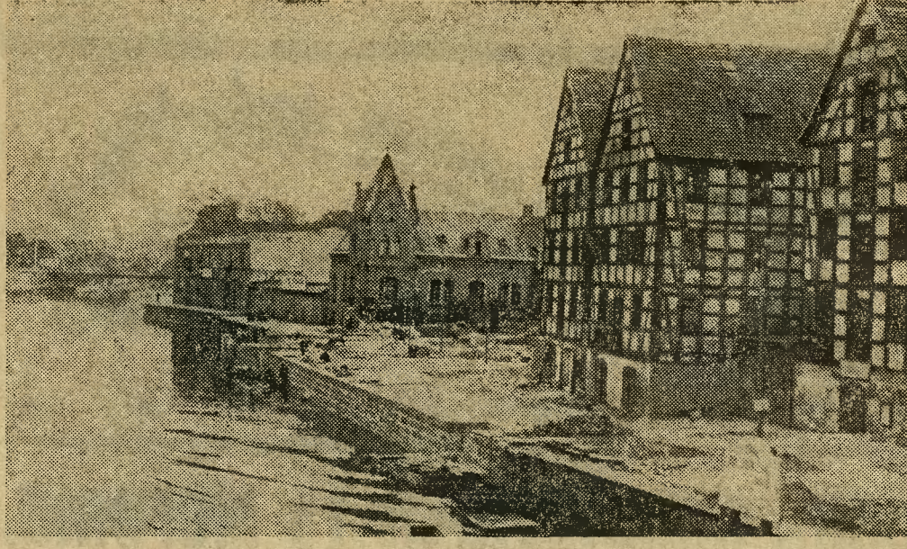
Jak widzimy na zdjęciu, prace nad wzmocnieniem brzegów Brdy dobiegają końca. Wyłożone blokami kamiennymi, prezentuje się nabrzeże prawdziwie po europejsku.
