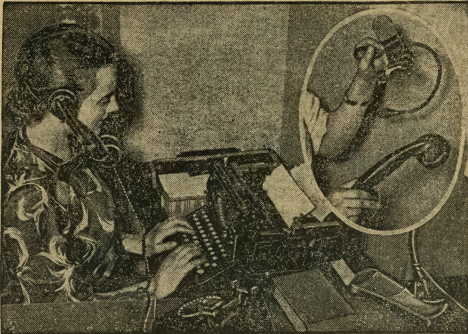
Berlińczyk Hildebrand skonstruował urządzenie, które pozwala stenotypistce zakładać słuchawkę telefoniczną na głowę i utrwalać dyktowane dźwięki, a następnie wprost je przepisywać.
