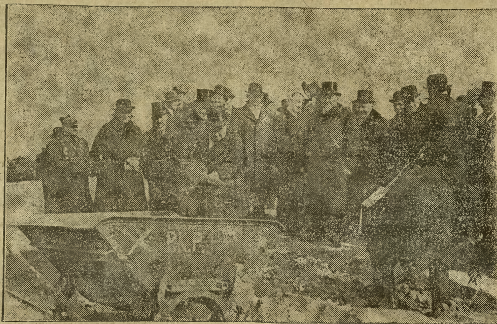
W niedzielę odbyła się na Okęciu o godz. 11 rano uroczystość poświęcenia rozpoczęcia robót i budowy linii kolejowej Warszawa — Radom. Na uroczystość przybyli: p. premier Prystor, marszałek Sejmu Świątalski, — ministrowie Butkiewicz, Hubicki i Zarzycki, oraz liczni wyżsi urzędnicy państwowi. Licznie zgromadzona okoliczna ludność brała również udział w uroczystości. Na zdjęciu naszym widzimy p. premiera Prystora (x) oraz ministra Hubickiego, dokonującego symbolicznego rozpoczęcia robót rzucając pierwszą łopatę ziemi.
