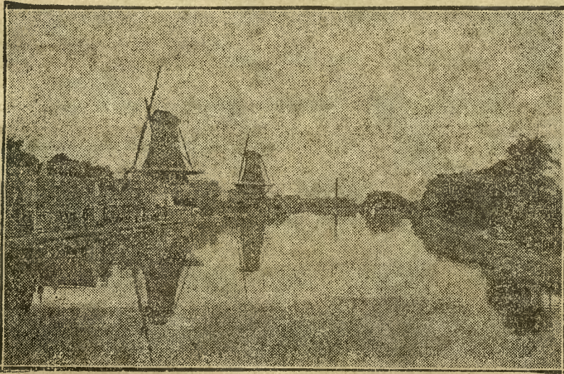
Na zdjęciu naszym widzimy typowy krajobraz z Holandji krainy kanałów i kwaterów. Cała Holandia jak wiadomo pocięta jest licznymi kanałami, wybudowanymi w celu odwodnienia terenów leżących częstokroć niżej poziomu morza. Ilustracja nasza przedstawia jeden z tych kanałów, nad którym ustawiono kilka wiatraków mających na celu utrzymanie należytego poziomu wody w kanale.
