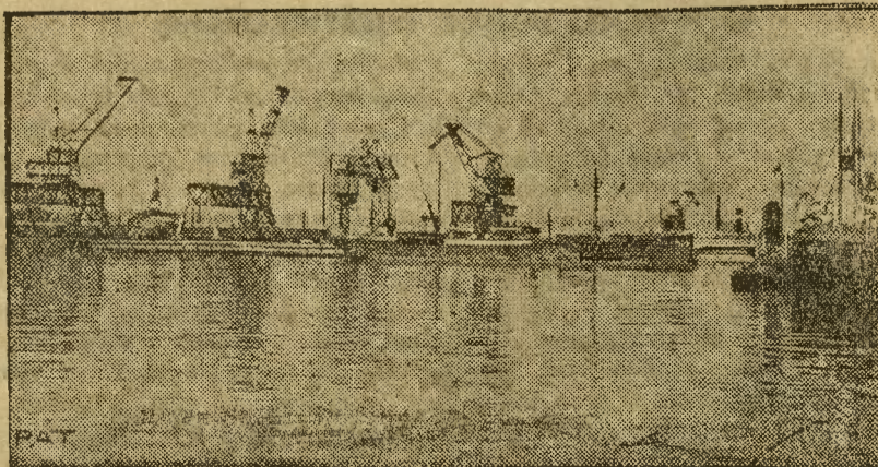
Krany przeładunkowe na nadbrzeżu szwedzkim basenu węglowego są nie tylko świetnym wyposażeniem technicznym portu gdyńskiego, ale i czynnikiem jego nowoczesnego piękna
