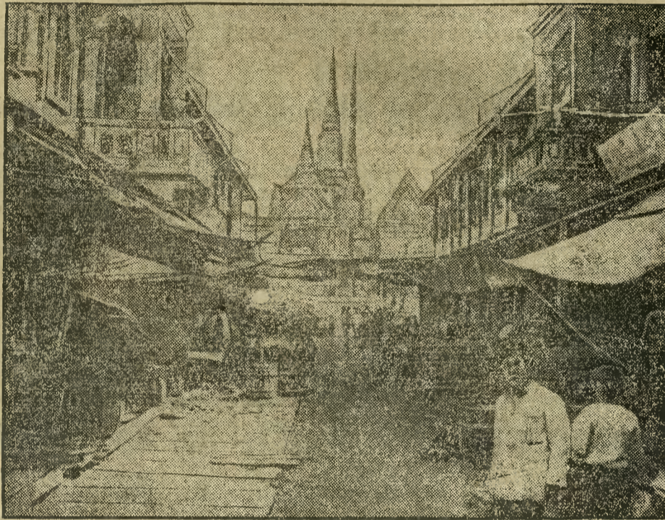
W stolicy Sjamu Bangkok wybuchł olbrzymi pożar, który w krótkim czasie przybrał niezwykle groźne rozmiary i rozszedł się nacale dzielnice. Pastwą pożaru padło przeszło 500 domów, w tym gmach jednego z banków zagranicznych. Powyżej widok na ulicę w Bagkoku. U wylotu ulicy jedna ze sławnych pagod.
