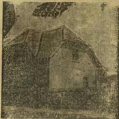
Nowa budowa naszego członka urzędnika kolejowego p. Franciszka Puchowskiego, Tczew, ul. Wybickiego 17.
