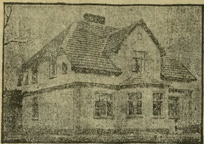
Nowa budowa naszego członka
