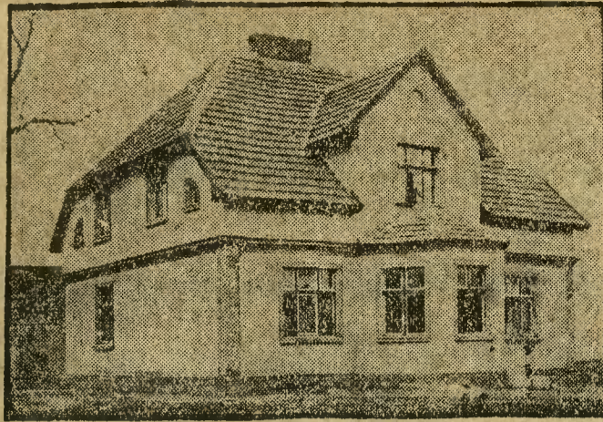
Nowa budowa naszego członka urzędnika kolejowego p. Bernarda Bieszki, Smolno, pow. Morski
