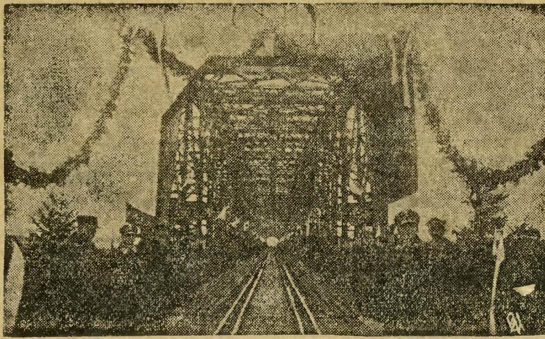
Ogólny widok nowowyprowadzonego mostu na rzecze Horyń, koło Antonówki na linii kolejowej Sarny—Kowel. Otwarcie mostu nastąpiło dnia 2 bm.
