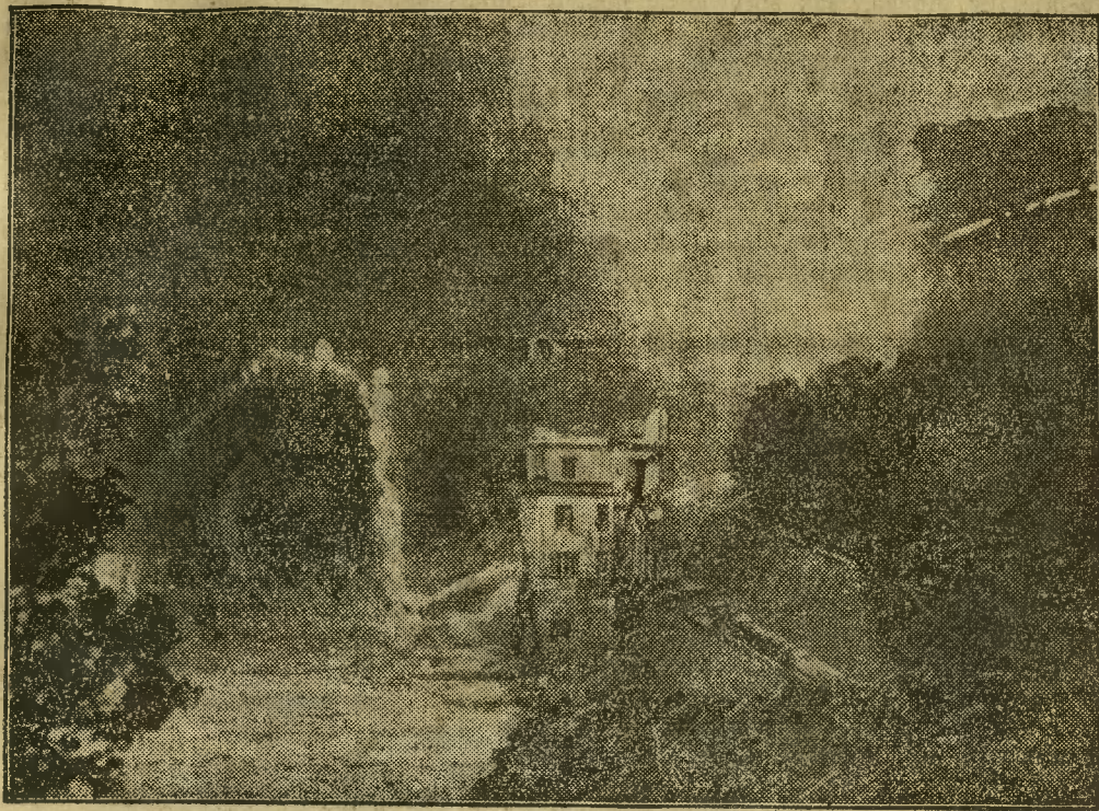
Na zdjęciu powyższym uchwycono pierwsze chwile katastrofy; na pierwszym planie widzimy halę turbin elektrowni, która została zburzona. Z prawej strony z gór olbrzymie masy wód spadają w dolinę, szerząc zniszczenie.
