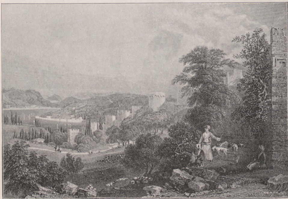
Mury miejskie w stronie północno-wschodniej.
